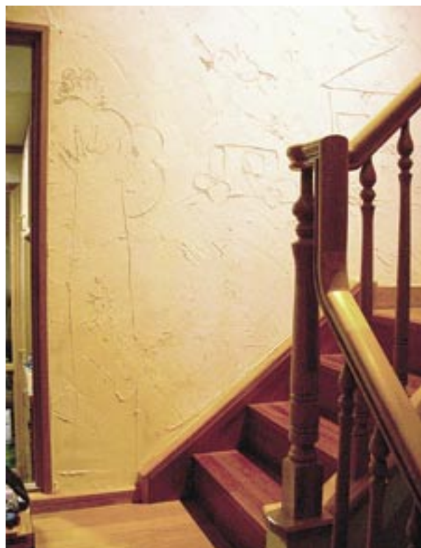
階段の吹き抜けに施工したアロエ化石の塗り壁。子供が自由に描いた絵の跡がそのまま残っている。
