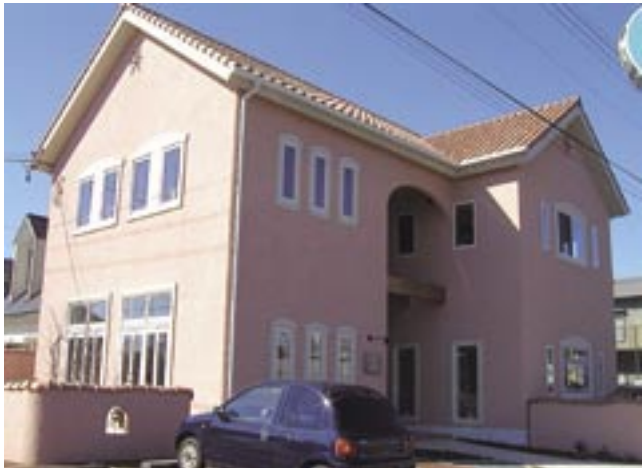
エバーウォールによる外装仕上げ
