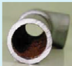
装着後の水道管
