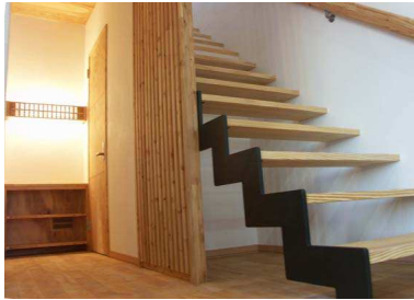
鉄桁と格子の標準階段
