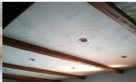
梁アラワシに塗り壁仕上げの組合せ
