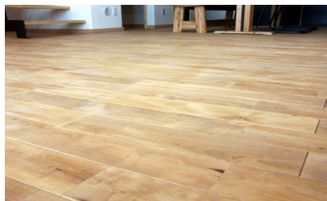
カバフローリング自然塗料仕上げ
